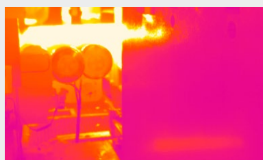
熱間圧延エリアの温度監視
